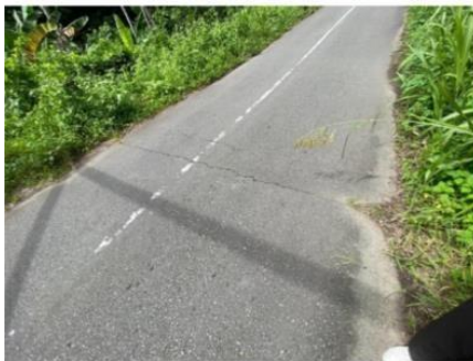
Gambar 3. Siar Muai Jembatan Wai Boyan Sumber: Dokumentasi
