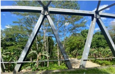
Gambar 10. Rangka Diagonal Jembatan Wai Boyan Sumber: Dokumentasi
