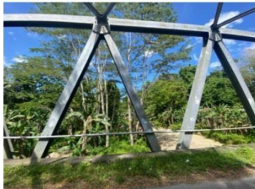
Gambar 7. Tiang Railing Jembatan Wai Boyan Sumber: Dokumentasi
