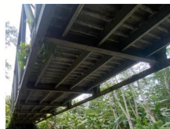
Gambar 9. Rangka Bawah Jembatan Wai Boyan Sumber: Dokumentasi
