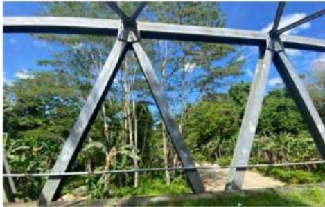
Gambar 10. Rangka Diagonal Jembatan Wai Boyan Sumber: Dokumentasi
