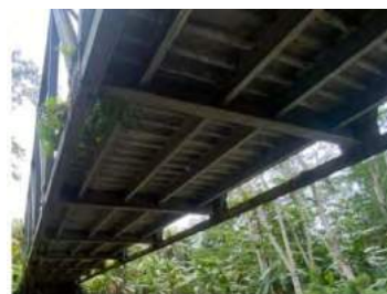
Gambar 9. Rangka Bawah Jembatan Wai Boyan Sumber: Dokumentasi
