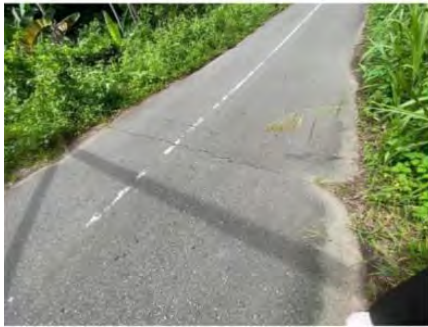
Gambar 3. Siar Muai Jembatan Wai Boyan Sumber: Dokumentasi
