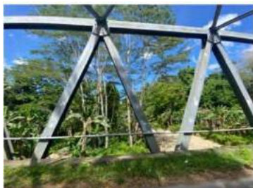
Gambar 7. Tiang Railing Jembatan Wai Boyan Sumber: Dokumentasi
