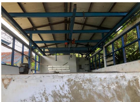
Gambar 6. Kondisi Pabrik Es di dalam
