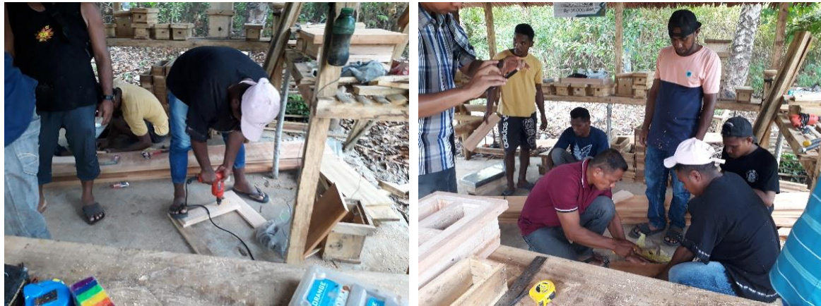
Gambar 3. Pembuatan lubang dan perakitan stup
