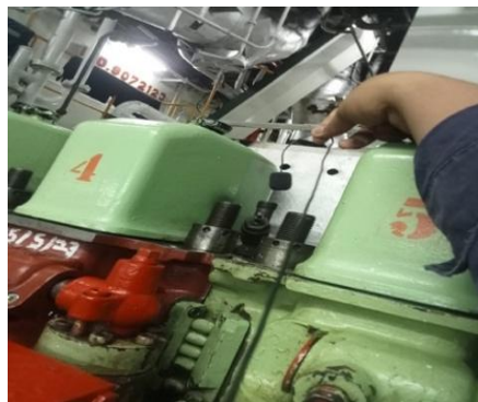
Gambar 2 Titik pengukuran pada mesin induk
