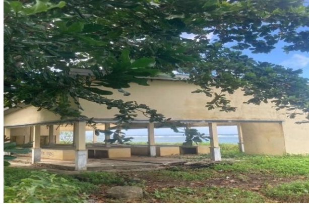
Gambar 1. Pasar Rakyat Hutumuri
