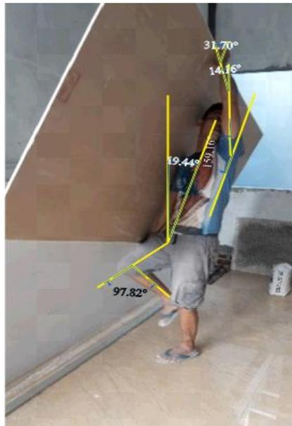
**Gambar 4.** Proses Pengangkutan Plafon Gypsum
