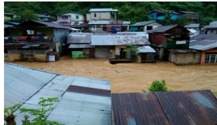
Gambar 1. Kerusakan Rumah Warga Akibat Banjir
