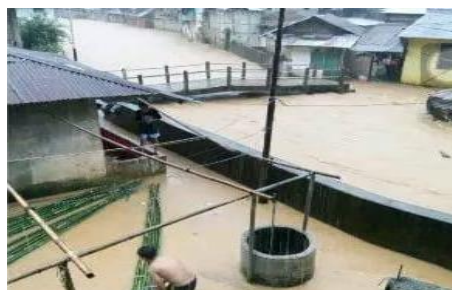
Gambar 2. Kerusakan Jalan Akibat Banjir
