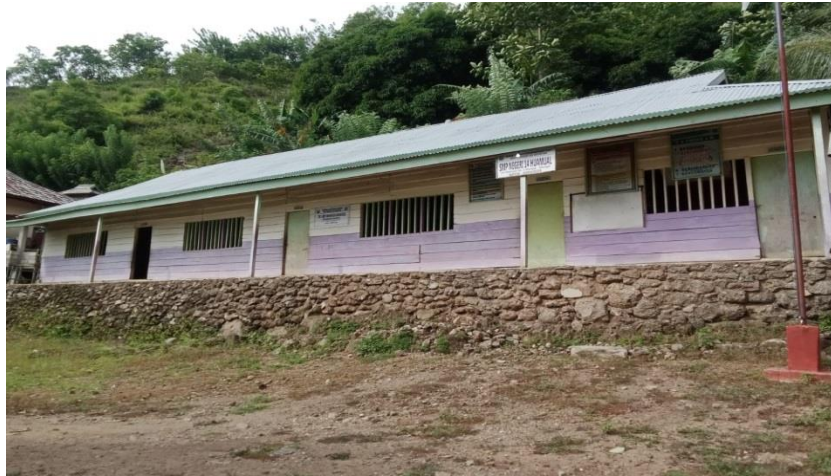
Gambar 2 : dari gambar di atas merupakan dokumentasi sekolah SMP Negeri 14, di wilayah dusun mangge-mangge yang gedungnya masih sangat sederhana
