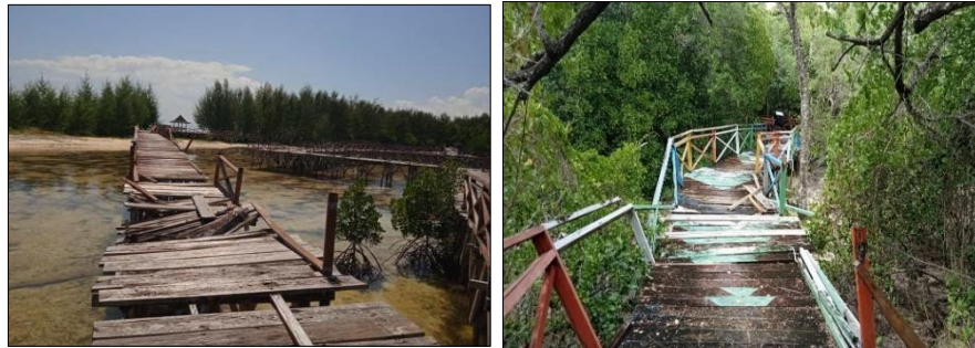
Gambar 2. Kondisi Jembatan Hutan Bakau (Sumber: Hasil Dokumentasi Penelitian 2024).
