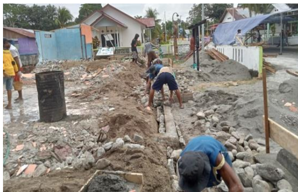
Gambar 1. Pembuatan Rumah Pustaka (Kantor Desa Hatunuru) Tahun 2021
