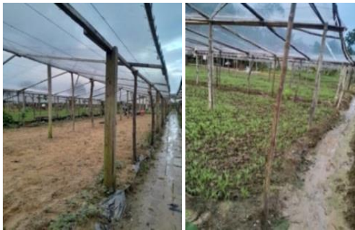
Gambar 3. Kondisi drainase tanaman kangkung desa poka
