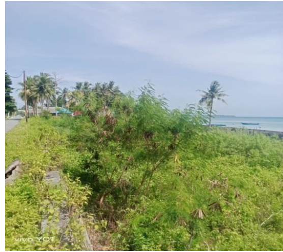
Gambar 1. Pengikisan Di Samping Badan Jalan Akibat Penggalian
