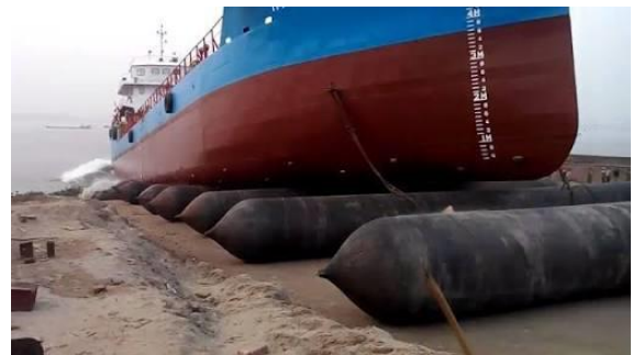
Gambar 1.2. Slipway menggunakan airbag (Rudan, 2012)[16]
