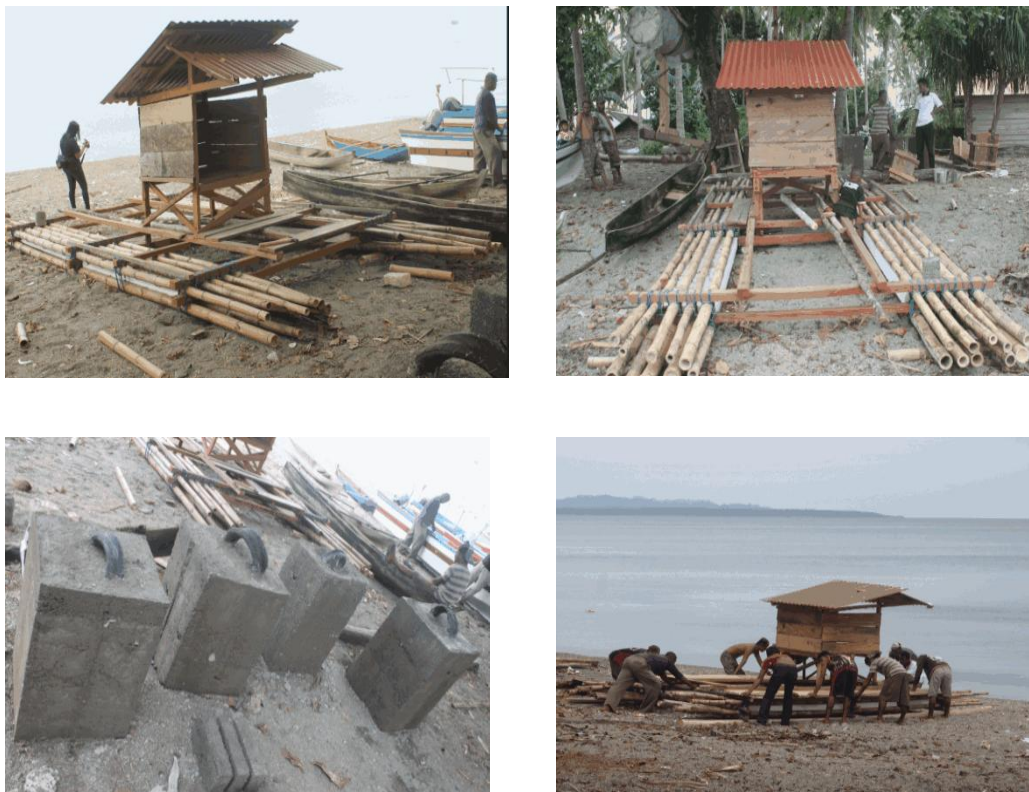
Gambar 2. Proses pembuatan dan perakitan rumpon ramah lingkungan (Biodegradable Fish Aggregating Device/FAD) oleh kelompok nelayan
