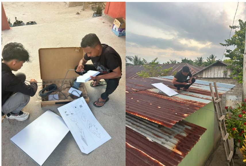
Gambar 10. Pemasangan starlink di atap rumah salah satu anggota mitra
