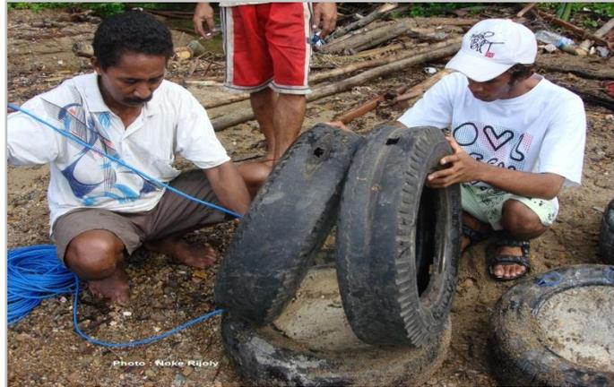
**Gambar 2.** Proses pengikatan segitiga ban sebagai konstruksi terumbu buatan
