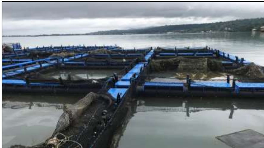
Gambar 2. Konstruksi KJA Berbahan Dasar HDPE
