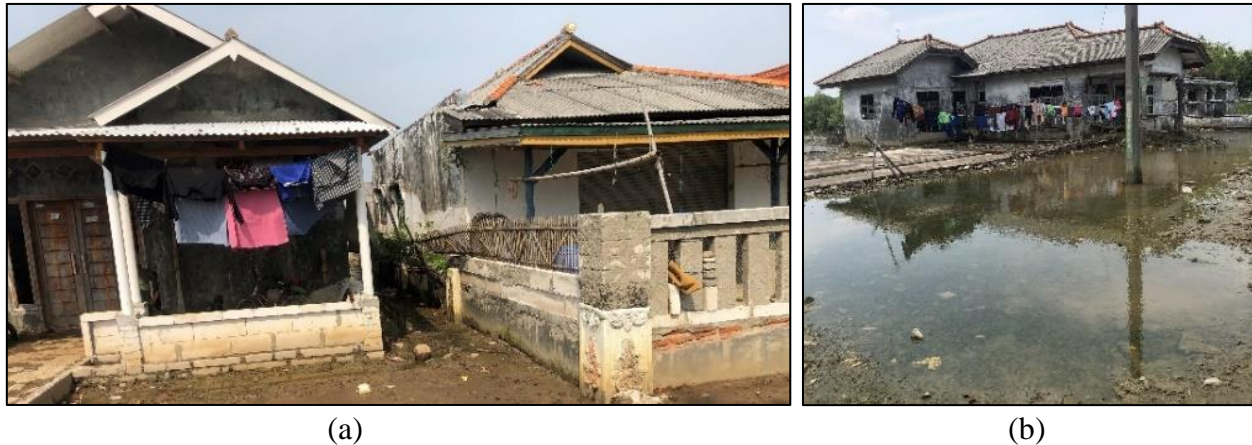
Gambar 2. (a) Beberapa Rumah Yang Ditinggikan Bagian Bawahnya dan (b) Rumah Yang Dibiarkan Tergenang (Dok. Penelitian, 2022).
