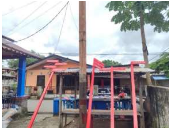
Gambar 5. Plang Nama Tempat/lokasi yang sudah selesai dibuat
