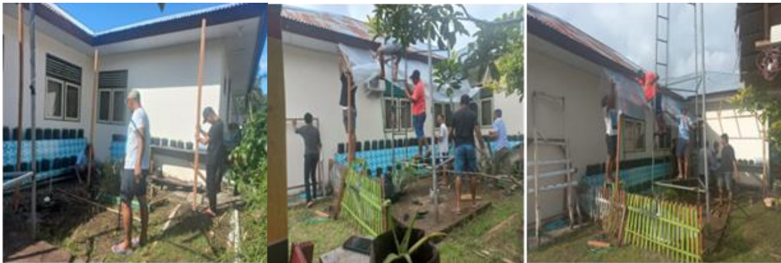
Gambar 3. Pemasangan Plastik UV
