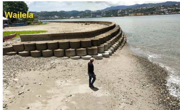
Gambar 6. Beberapa contoh dari berbagai bentuk dan ketinggian struktur pertahanan pantai yang ada di pantai Teluk Ambon pada bulan Maret 2022. Keterangan: Kiri atas: di Tantai; kanan atas: di Wayame; kanan tengah: di Poka; kiri tengah: di Rumahtiga; kiri bawah: Wailela.
