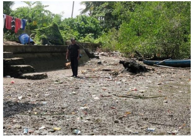
Gambar 8. Struktur pertahanan pantai yang dibangun di bagian belakang kawasan mangrove untuk melindungi daerah pemukiman di Passo. Foto bulan Maret 2022.
