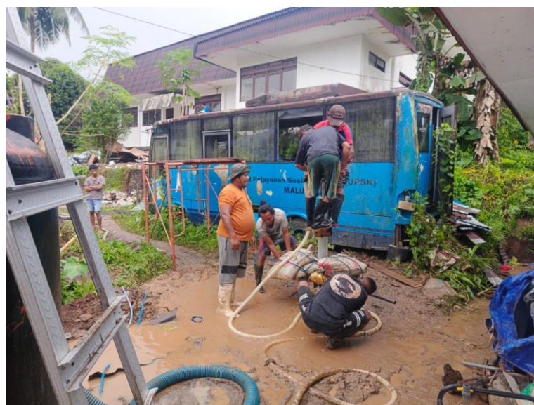
Gambar 4. Proses pengeboran pada titik yang direkomendasikan
