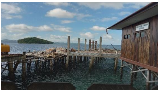
Gambar 5. Pembangunan Pasar (Dokumentasi Penulis)
