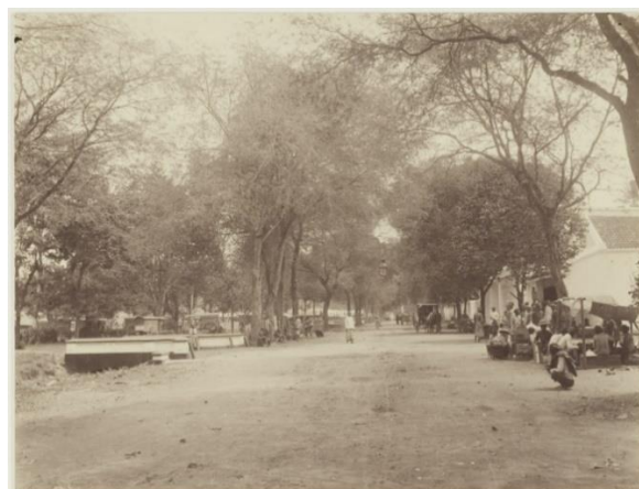
Gambar 20. Kotaweg te Blitar (Jalan Raya di Blitar) sekitar tahun 1900, dari bentuk jembatan dan sungai kecilnya, kemungkinan jalan raya utara Stasiun Blitar yang kini bernama jalan Mastrip. Sumber: KITLV Blitar.
