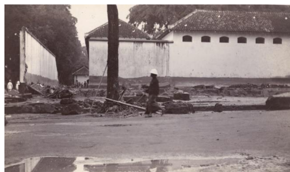
Gambar 6. Door lava en modder vervoeste ringmuur van de gevangenis te Blitar na de uitbarsting van de Keloed 1919 (Tembok Batas Lapas Blitar Hancur Lava dan Lumpur Pasca Letusan Keloed 1919) (Terletak di Hereenstraat kini jalan Merdeka) Sumber: KITLV Digital.
