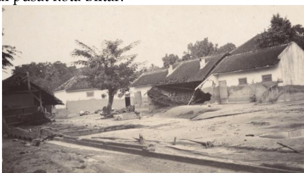
Gambar 5. Ingestorte bijgebouwen van de regentswoning (kaboepaten) te Blitar na de uitbarsting van de Keloed Mei 1919 (Runtuhnya bangunan luar kediaman bupati (kaboepaten) di Blitar pasca letusan Keloed Mei 1919) (Kawasan Pendopo Kabupaten Blitar, kini jalan Semeru Kota Blitar) Sumber: KITLV Digital.
